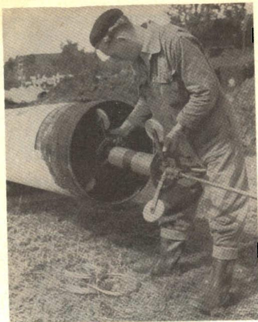
Fig. 11 - Applicazione dei raggi generati da un radioisotopo (iridio-192) per radiografare le saldature di un oleodotto. Il recipiente con la sorgente di radiazioni viene introdotto nel tubo su una specie di carrello e quindi spinto sul luogo della saldatura, dove una lastra a raggi X è collocata intorno al tubo. La sorgente è azionata, e la lastra esposta, mediante comando da lontano. (Fotografia scattata per gentile concessione del « Servizio Tecnico Röntgen », Rotterdam).
